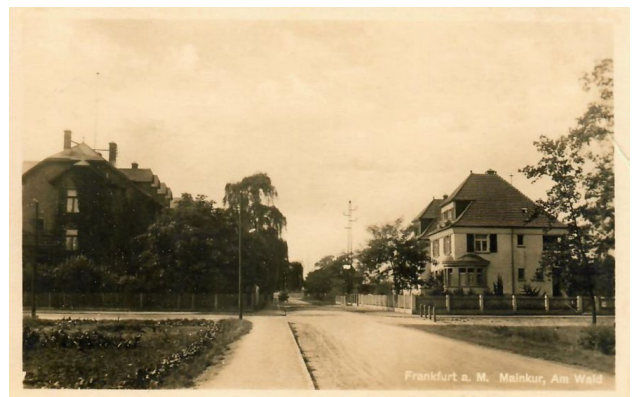
DIE STRASSE KURZ NACH DER FERTIGSTELLUNG
